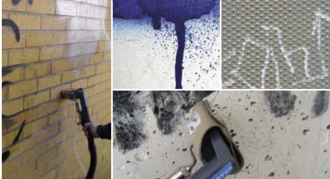
Mit Graffiti besprühte Wände und Böden werden mit Gregomatic wieder sauber – unabhängig von Material und Oberflächenbeschaffenheit. Bilder: Gregomatic AG
