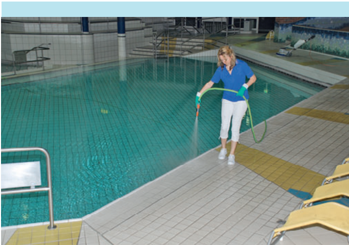
Die Flächen rund um die Becken werden in der Therme Bad Griesbach nach dem Einschäumen – im Wechsel sauer und alkalisch – noch mit einem Schlauch abgespritzt und mit einem Wasserschieber abgezogen.
